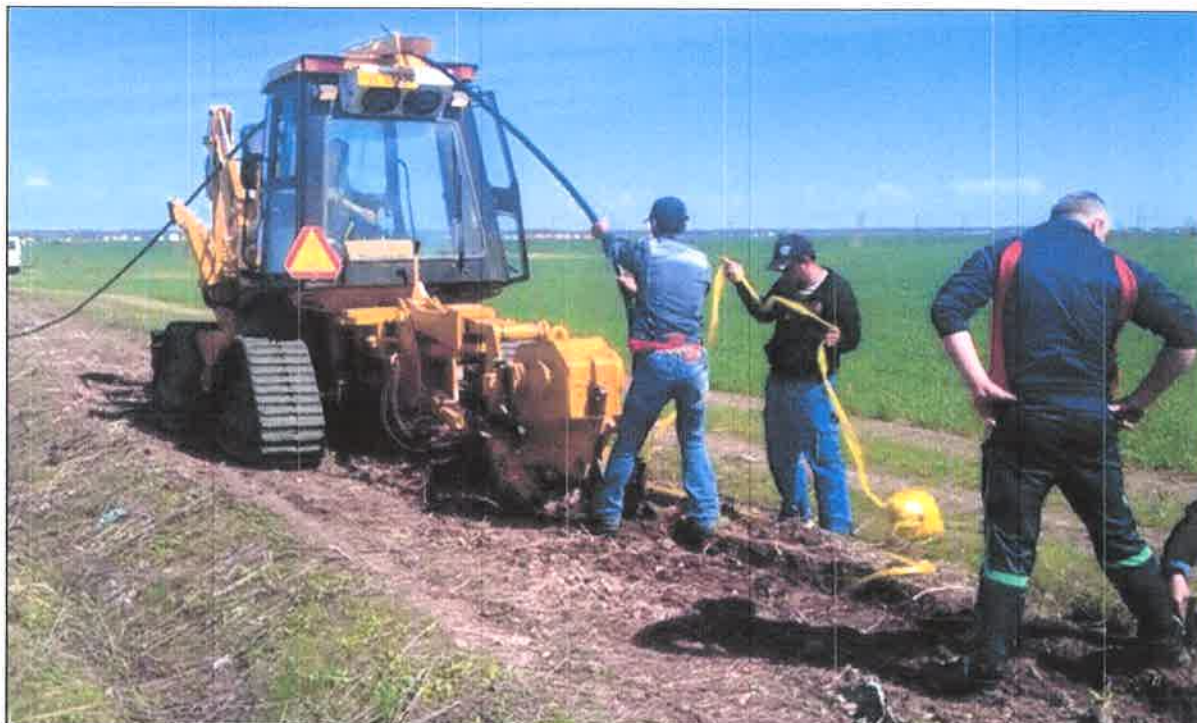
Instalare cablu F.O. aerian.
