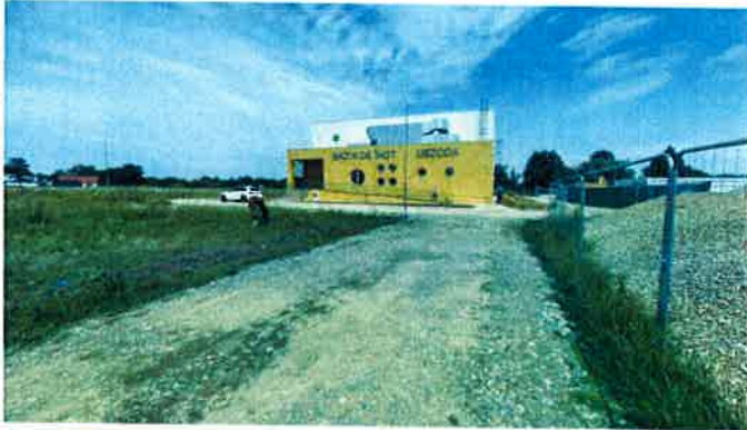
Fig. 22_sus_Proiect bazin de înot finalizat recent în zona de agreement
