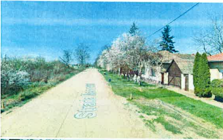
Fig 16_ stânga sus_ Strada Menumorut Fig. 17_ stânga jos_ Strada Victor Hugo
