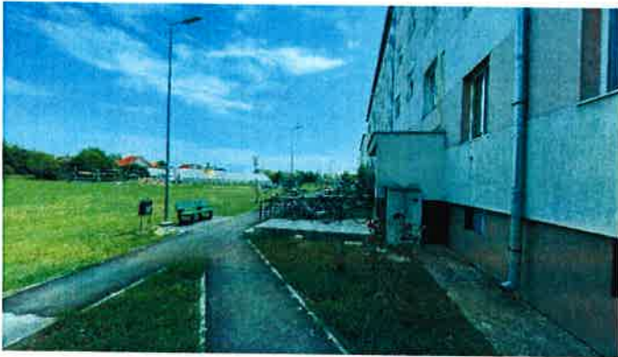
Fig. 19_Locuințe sociale existente (ANL)
